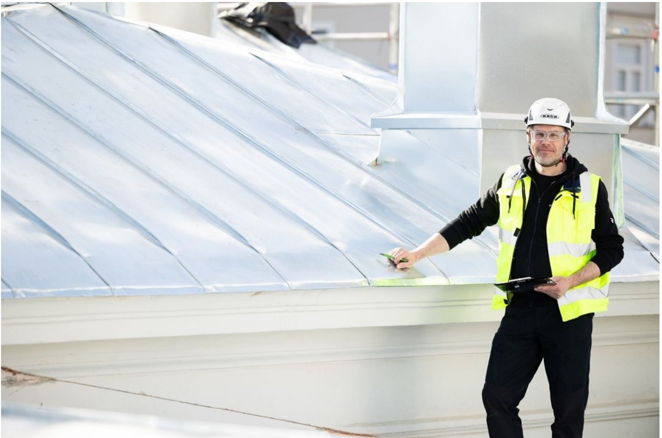
Porin taidemuseon katolta, Rami Lahti rakennustyönvalvojana tarkastamassa vesikatteen asennustöitä.
