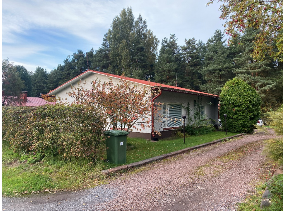
Suunnittelualueen kiinteistön 79-203-17-4 päärakennus.
